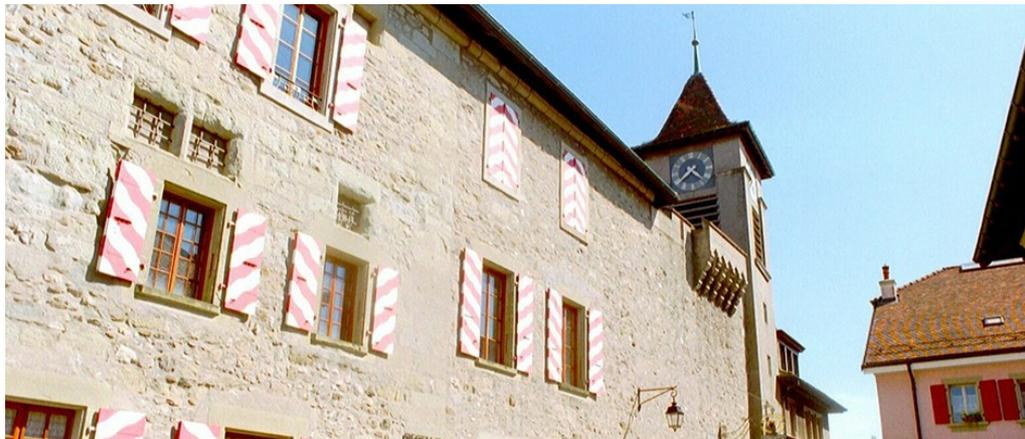
L'actuel bâtiment du Prieuré est en état d'obsolescence avancé, tant au niveau de la structure portante (risques d'écroulement de certains planchers) que de ses infrastructures techniques (chauffage et sanitaires défectueux). Le défaut d'isolation des murs et de la toiture n'est plus tolérable à l'heure du réchauffement climatique et des recherches d'économies de consommation énergétique.
